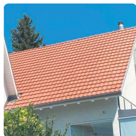
Dach ca. 1 Jahr später.
